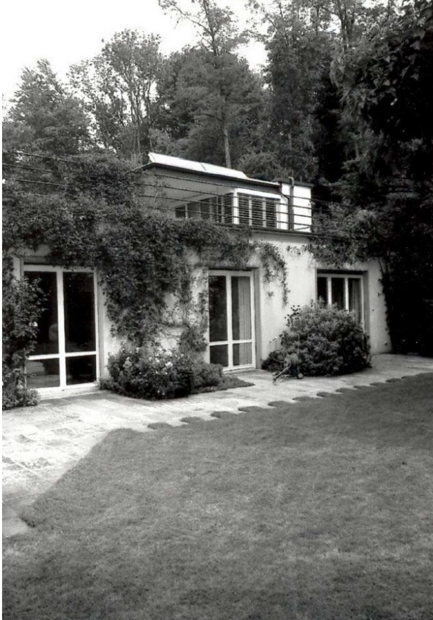
BIB: Waldrain 2 von Süden
