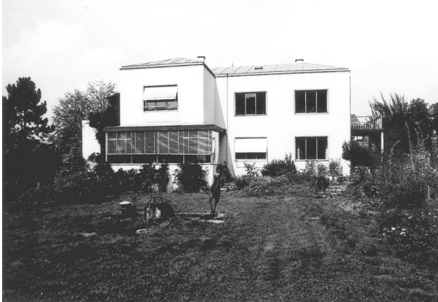
BIB, Waldrain 6 von Süden
