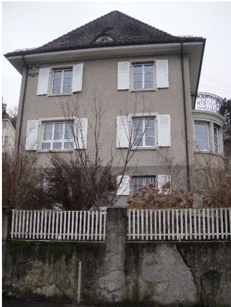
Ruchholzstrasse 44 von Westen
