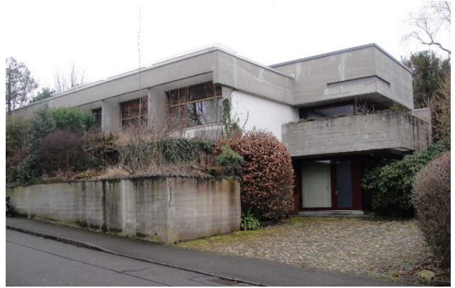
Bodenackerstrasse 2 von Osten (Eingangsbereich)
