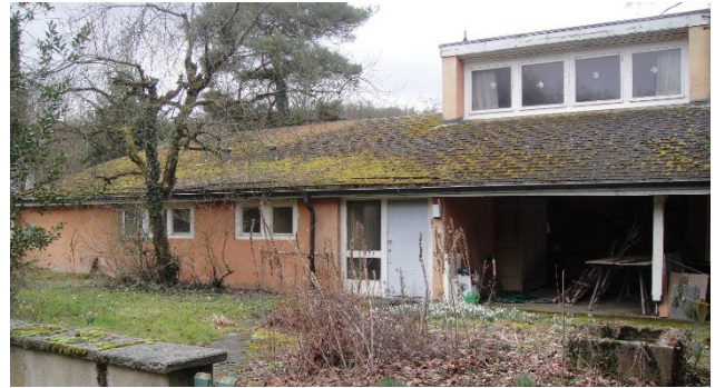
Weichselmattstrasse 26 von Norden
