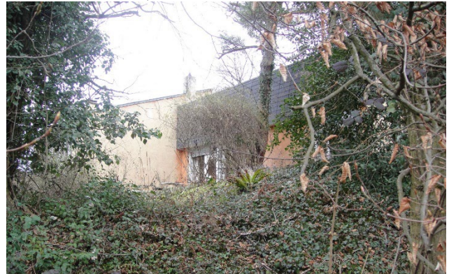
Weichselmattstrasse 26 von Süden (Gartenseite Wohnhaus und Atelier)
