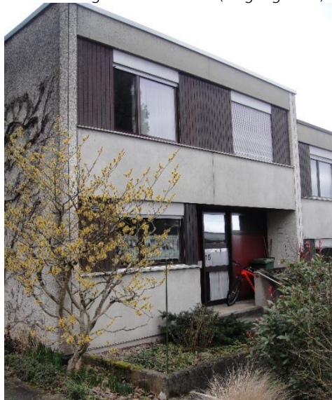
Talmattweg 15 von Westen (Eingangsseite)
