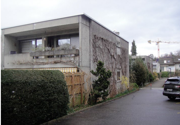
Talmattweg 1-23 von Südwesten (Südostenseiten)
