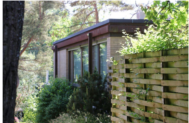
Weichselmattstrasse 22 von Nordosten
