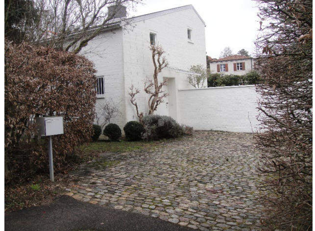
Im Erlisacker 12 von Südwesten (Eingangsbereich)
