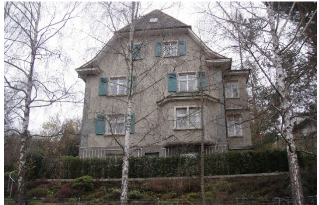
Ruchholzstrasse 36 von Westen
