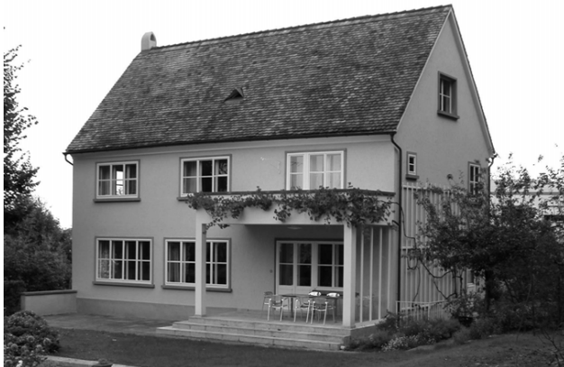
BIB: Waldrain 4 von Süden
