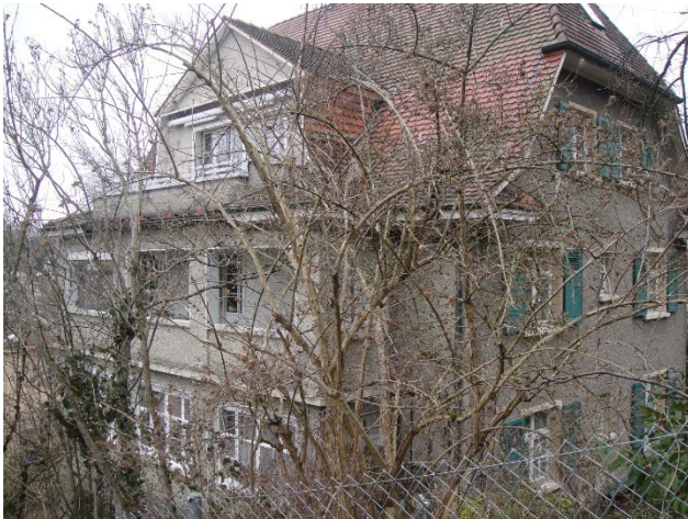
Ruchholzstrasse 36 von Südosten
