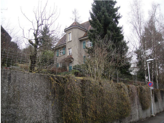
Ruchholzstrasse 36 von Norden
