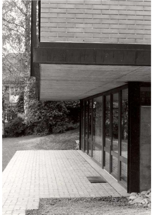
BIB, Weichselmattstrasse 22 von Südwesten, um 1970
