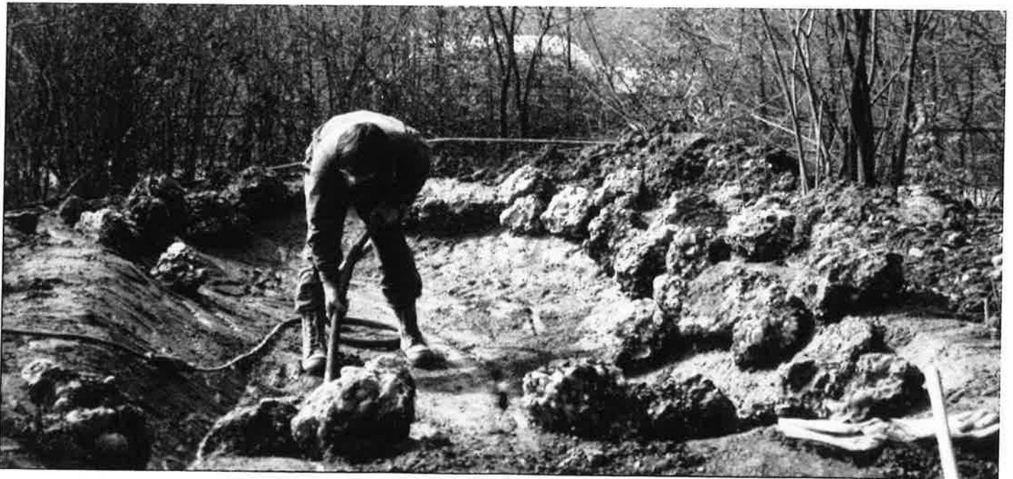
A. Ochsenbein beim Betonieren der beiden Laichbecken im Norden des Schilfweihers.
