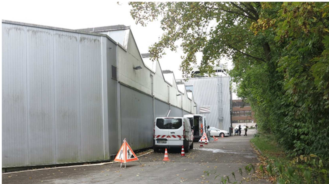
Sanierungsbereich zwischen Industriegebäude und Birsig-Böschung
